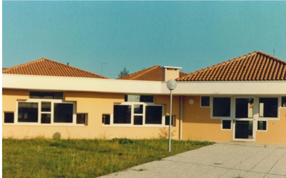
1986 - Asilo nido a Quarto d'Altino - finestre in PVC Soteco.
