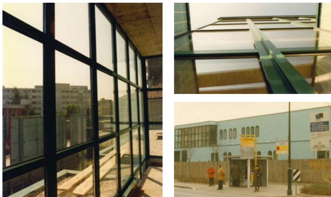
1990 - Piscina comunale di Mestre (Ve) - finestre in PVC Soteco.
