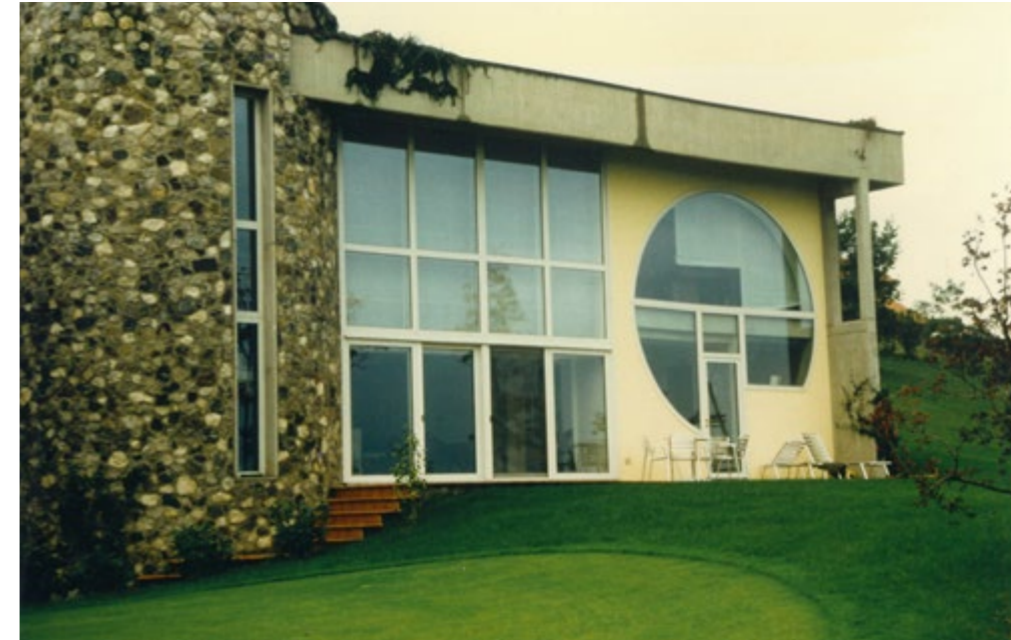
1989 - Villa a Fagagna (Ud) - finestre in PVC Soteco.
