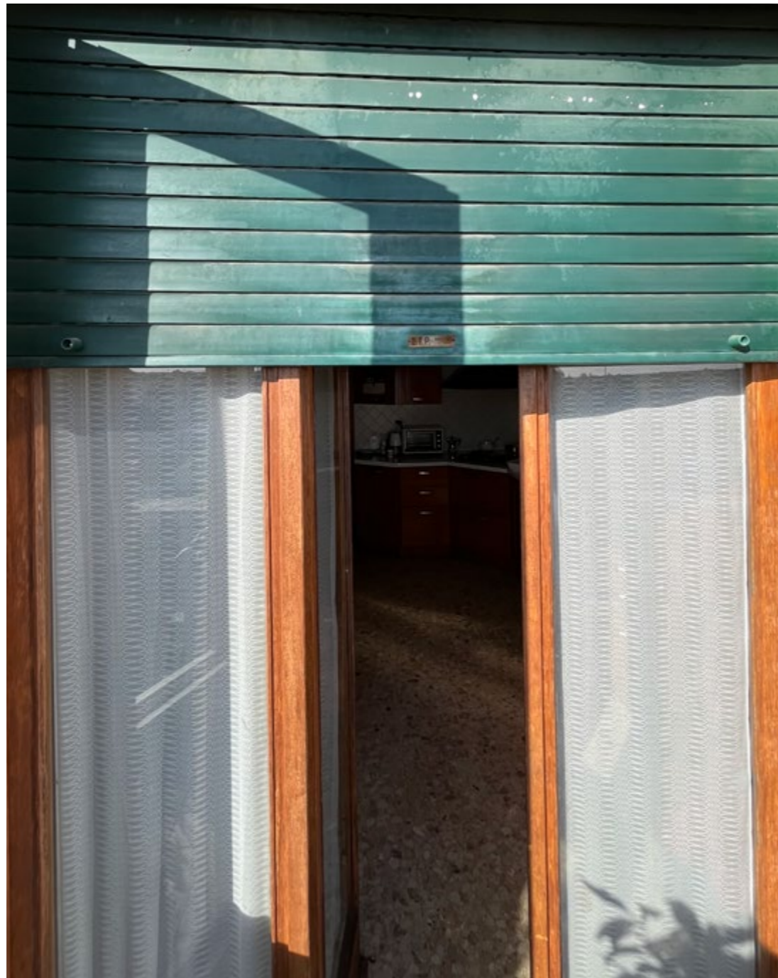
Tapparella in PVC installata in un appartamento di Mestre (Ve) nel 1970.
